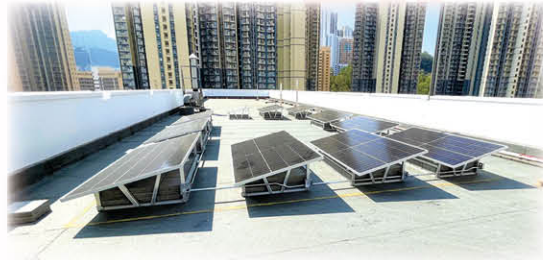
引入環保科技，在天台上安裝太陽能板。
